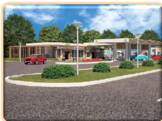
Строительство объектов придорожного сервиса
